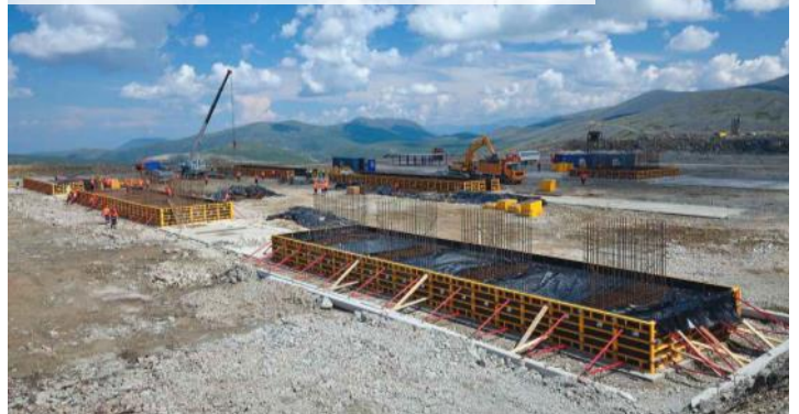
ウドカンスコエ銅鉱床の工場建設現場 =バイカル鉱山会社
